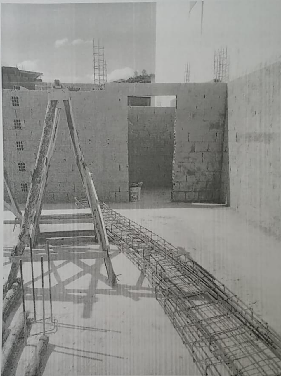
Foto 04 – Alvenaria 1º pavimento prontas para receber o vigamento
