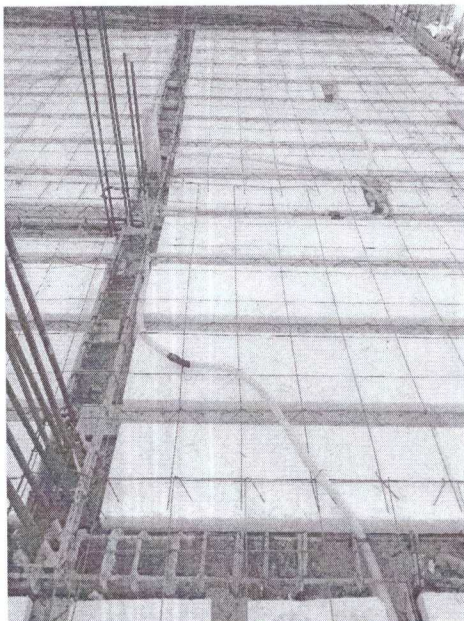
Foto 02 – Montagem da laje pré moldada
