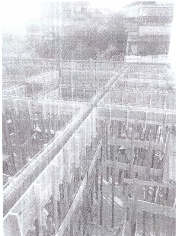
Foto 01 - Forma e cimbramento das vigas
