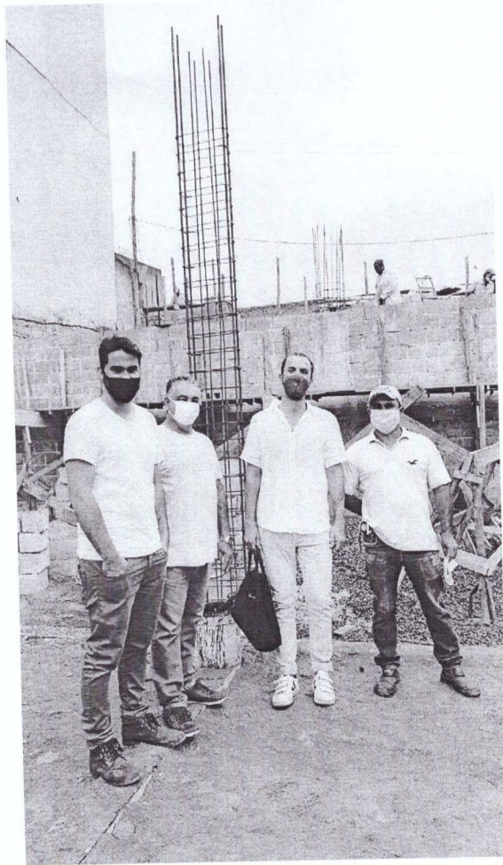
Foto 6 – Equipe na obra
