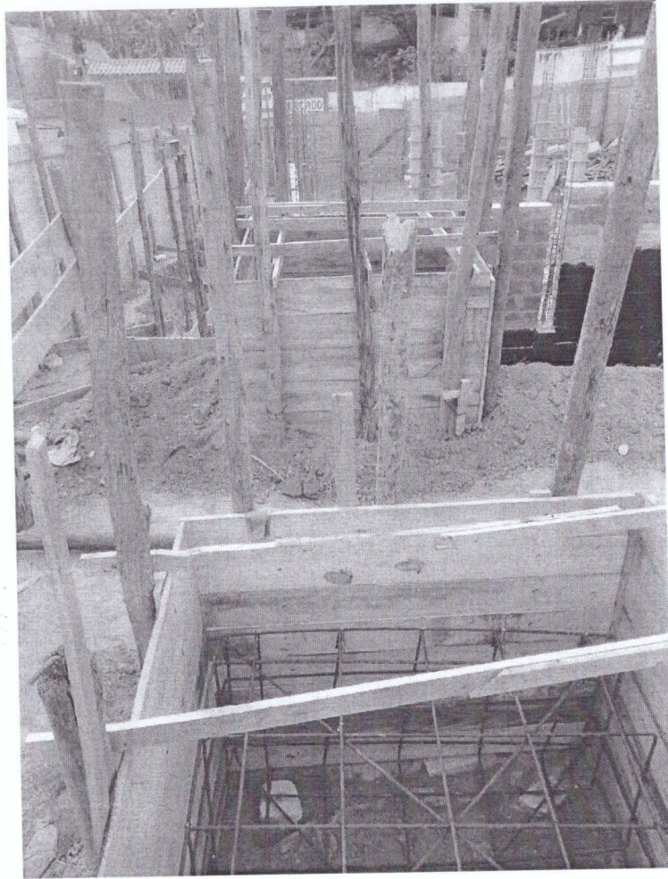
Foto 4 – Blocos de fundação aramados na plenária
