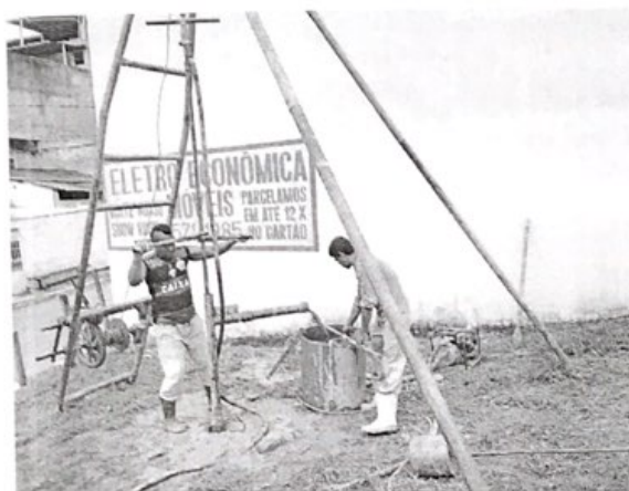
Foto 2 – Execução Sondagem SPT
