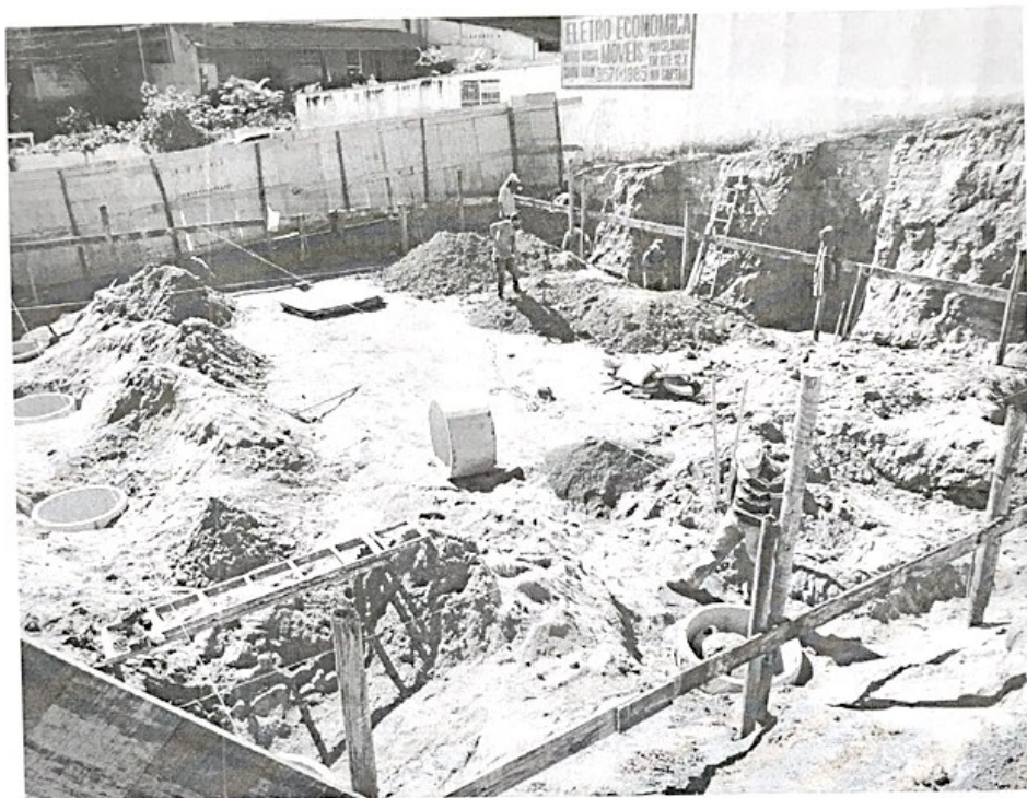
Foto 9 – Locação e Escavação das Fundações
