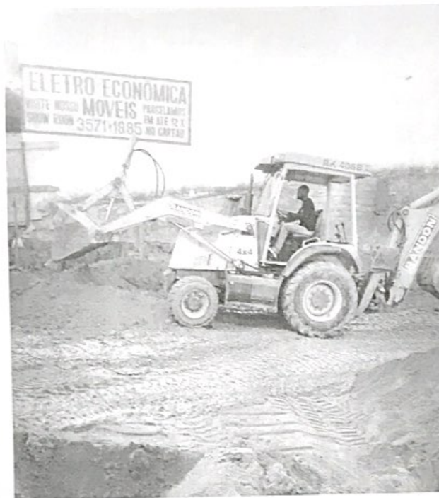
Foto 7 – Movimentação de terra
