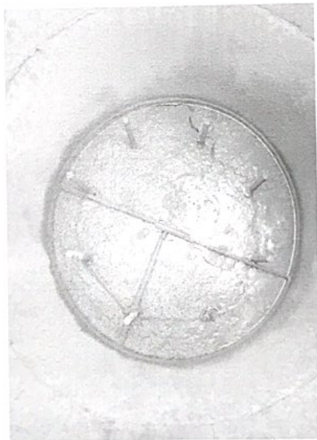
Foto 12 – Concretagem do Tubulão
