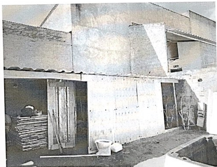
Foto 6 – Montagem barracão de obra
