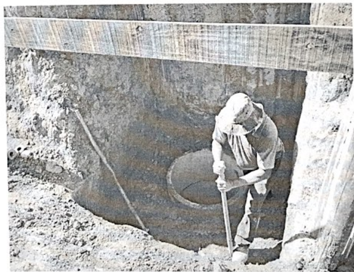
Foto 10 – Escavação blocos e tubulão
