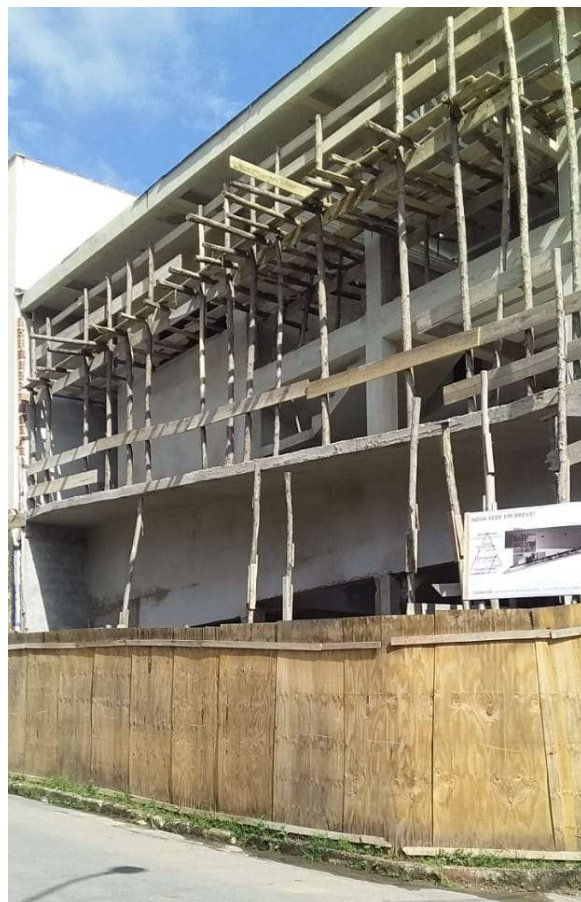
Vista geral da fachada da obra
