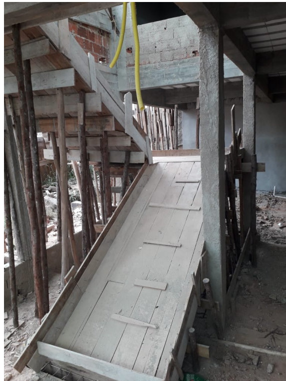
Fotografia 03 – Forma para Escada
