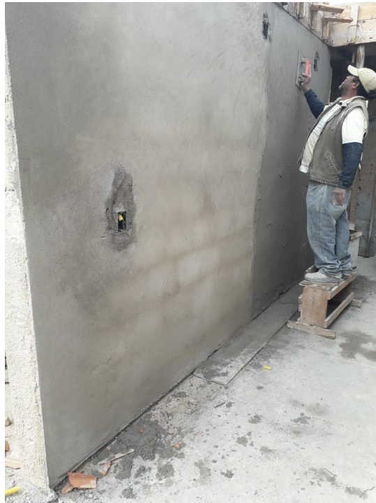
Fotografia 2 - Execução do Reboco
