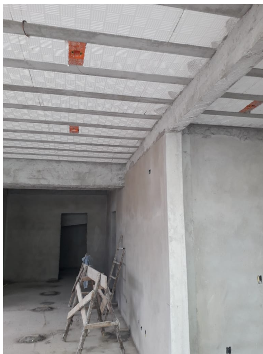
Fotografia 04 – Reboco interno 1º pavimento
