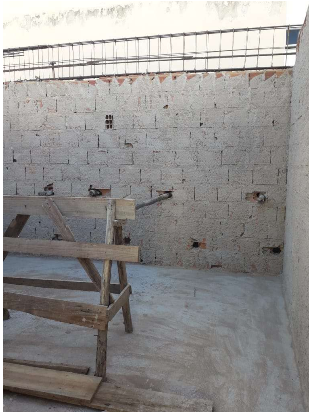
Foto 02: Vigamento terceiro pavimento
